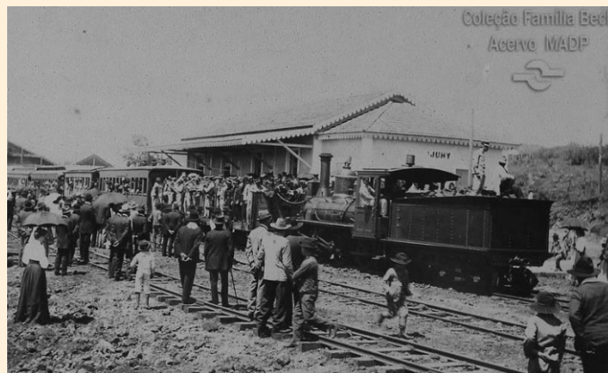
Inauguração da Estrada de Ferro em Ijuí - 1911
